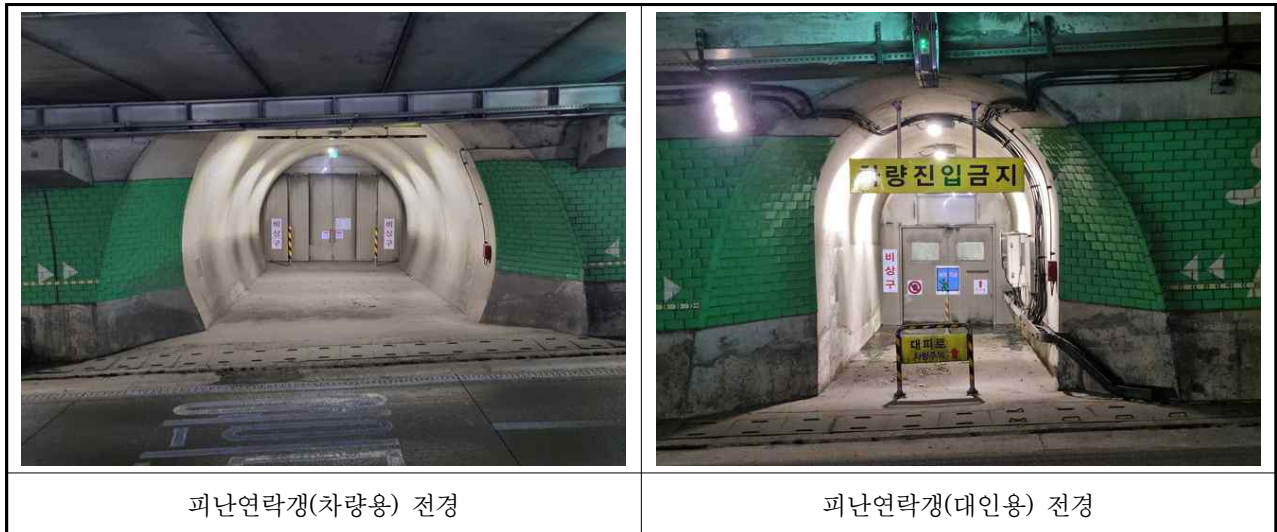
【사진 3.3.37】 피난연락갱 전경
